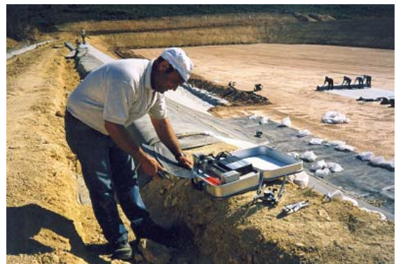
Fig. 12 Ensayo in situ de muestras de soldadura.
