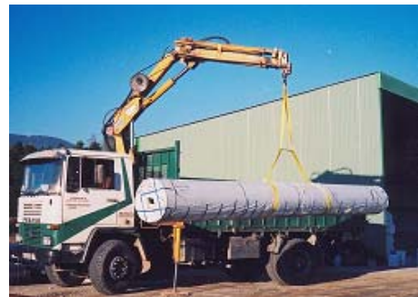
Fig. 1 Descarga de geomembrana de PEAD
