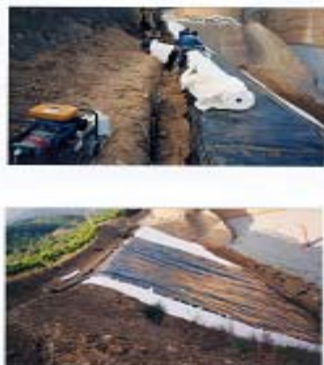
Fig. 4 Talud con zanja de anclaje
